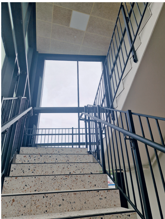
Hovedtrappeløpet med flis på gulv og spesielle himlinger.
