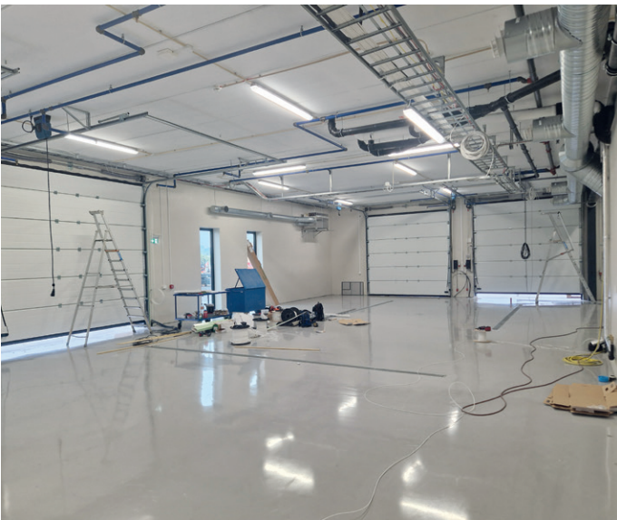
Fra garasjeanlegg som rommer fem ambulanser og med utkjøringsporter i fire retninger.
